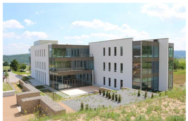
Blick auf den Anbau.
